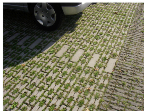
parkeervakmarkering met dichte klinker type 2
